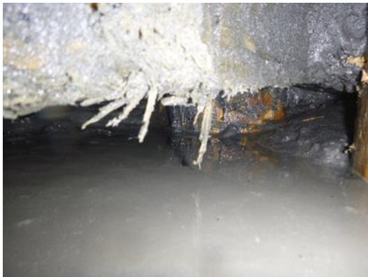
paal 1.4 geen indringing kunnen meten
