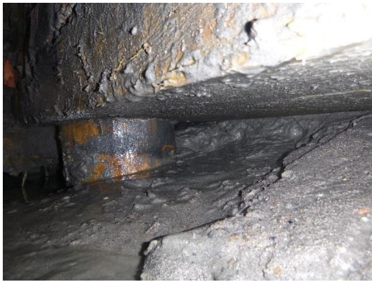
Langshout en paal 1.3
