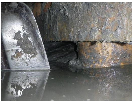
langshout en paal 1.2
