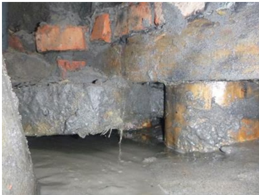
Langshout zijgevel en voorgevel
