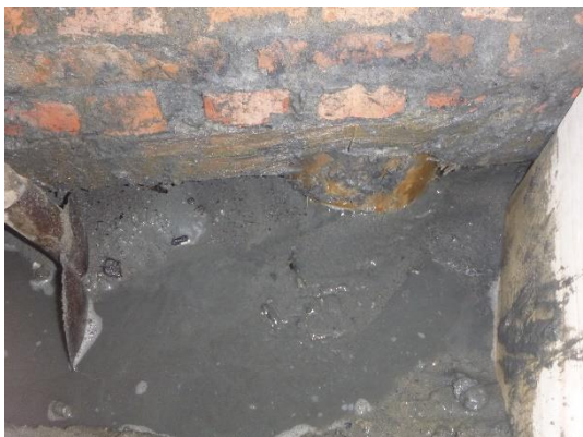
Langshout en paal 1.1
